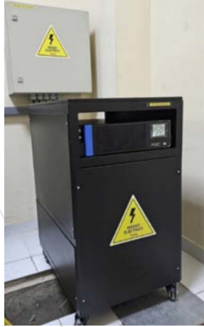
▲ Ilustración 1: Sala de tableros del aeropuerto internacional
