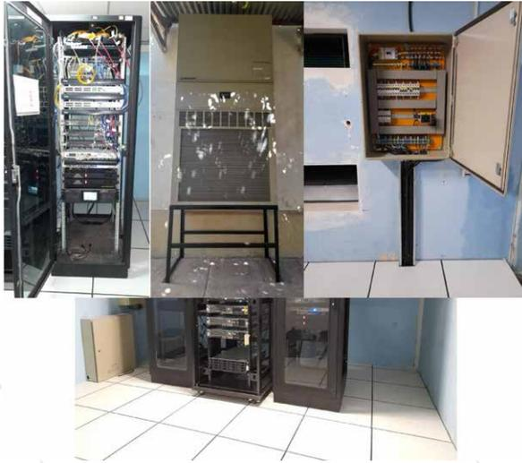
Una importante institución pública, requería la readecuación total de su CPD, para lo cual se implementaron diferentes equipos: un UPS de 20KVA para la protección de su carga crítica, un aire industrial de 12.3kW para mantener climatizado el ambiente, piso técnico para mantener aislada la instalación eléctrica y un nuevo tablero eléctrico que contemple un crecimiento, además de la organización de todas las cargas conectadas aguas abajo.
