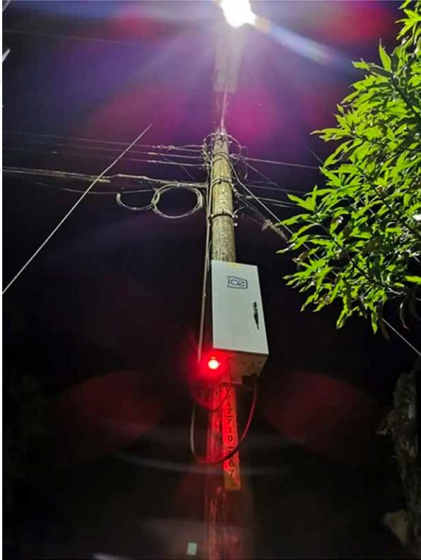
Esta mejora hace que el estado del Reconectador OSM sea visible a mayor distancia, desde la sala de control de la subestación, proporcionando un respaldo a las comunicaciones cableadas con el dispositivo. Esta Interfaz Hombre-Máquina también simplifica la formación de los operadores, ya que los técnicos no familiarizados con el equipo pueden ser instruidos de forma segura en una emergencia para llevar a cabo las operaciones.
