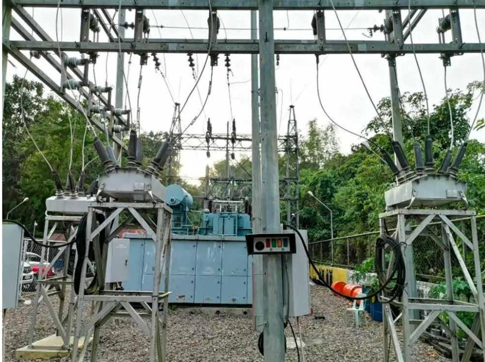
▲ Accesorio tipo semáforo en subestación (centro) conectado mediante un módulo I/O en Filipinas
