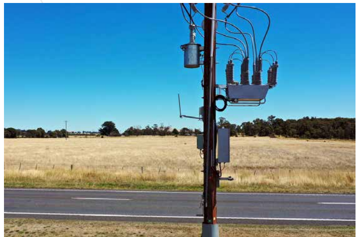
▲ Un reconectador OSM de NOJA Power en Victoria, Australia © NOJA Power 2023
